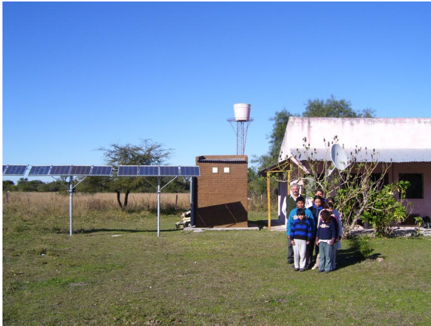
Figura 2.- Sistema fotovoltaico de 600Wp instalado en la escuela n° 49 Paraje Bernachea – dpt. de Empedrado – prov. de Corrientes, Argentina junto con el maestro y los alumnos de dicha escuela.
