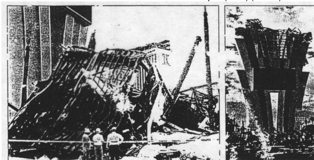
Foto 13.19.- Estructura después de colapso (1994) (Ref.47)
