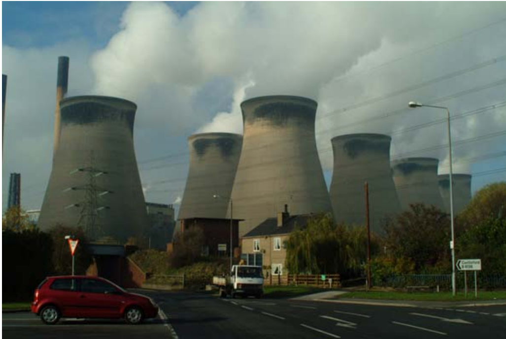
Foto 13.16 Torres de enfriamiento en la planta de FERRYBRIDGE (Ref. 5)
