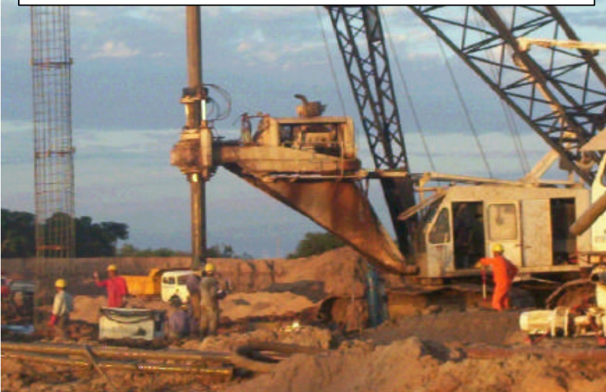
Pelotera empleada (a la izquierda armadura en colocación)
